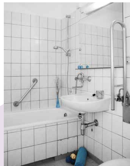
Die altersgerechten Bäder wurden saniert
