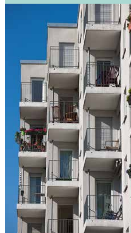
Damit auch die obersten Etagen gut erreichbar sind
